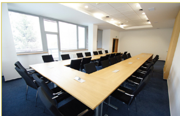
Konferenčná miestnosť F119 po rekonštrukcii
