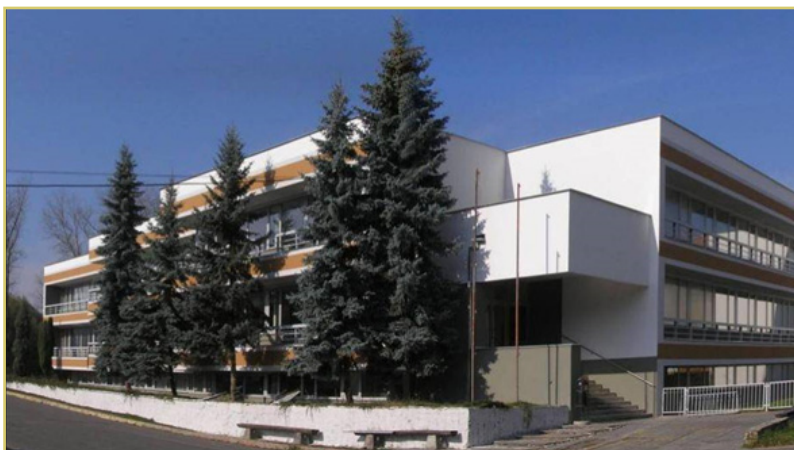
Budova FT po rekonštrukcii v roku 2008
